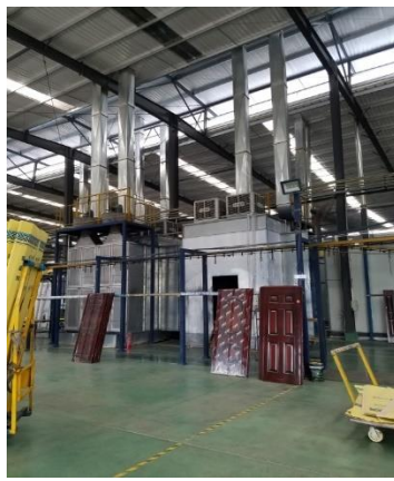
图 4.5 现场水帘喷漆房图片
